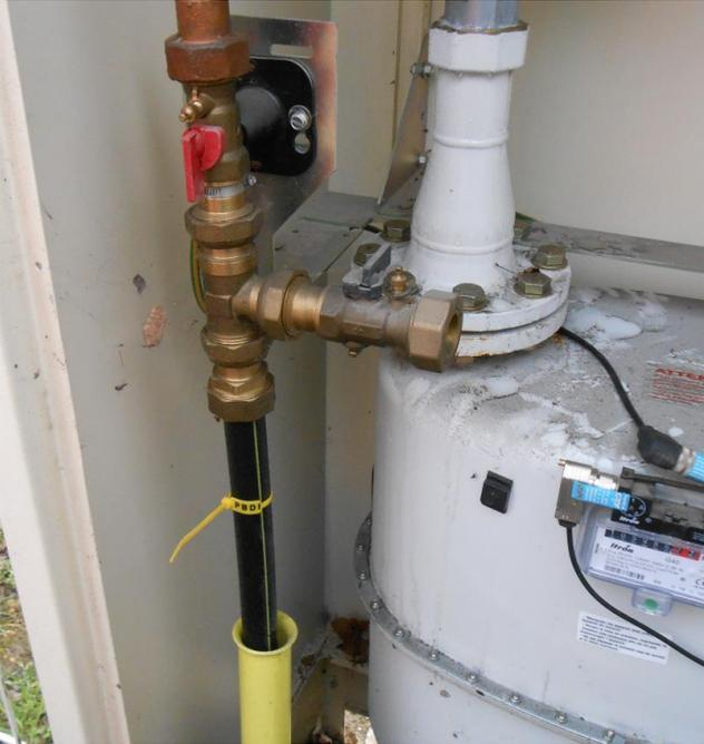
Arrivée d'eau potable en canalisation isolante
